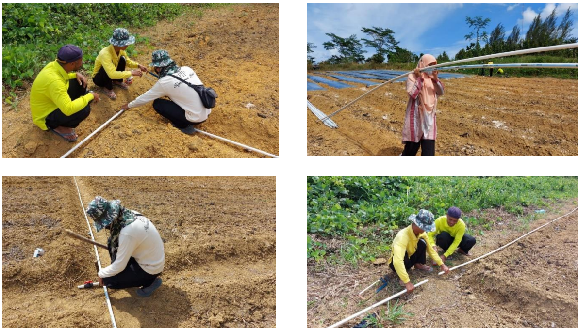
Gambar 64. pemasangan pipa saluran penyiraman di lahan kedelai
