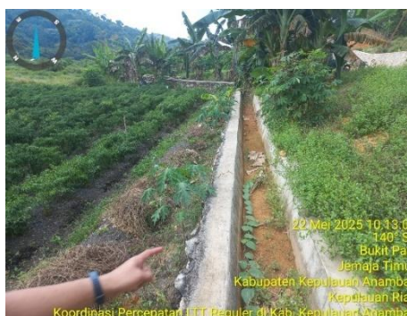
Kondisi saluran irigasi tersier
